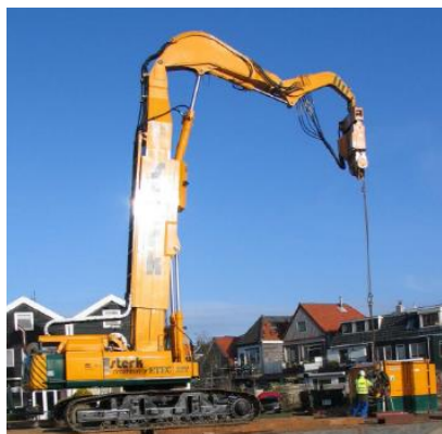
Sheetpiler voor het aanbrengen van de damwanden
